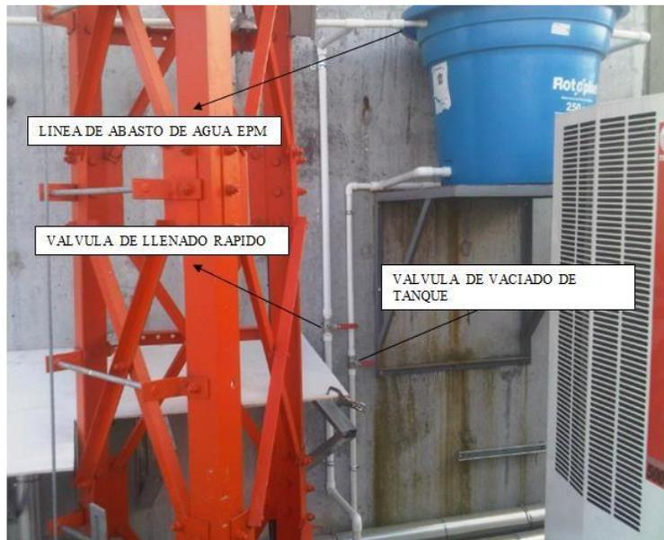
Ilustración 4. Válvulas y línea de abasto
