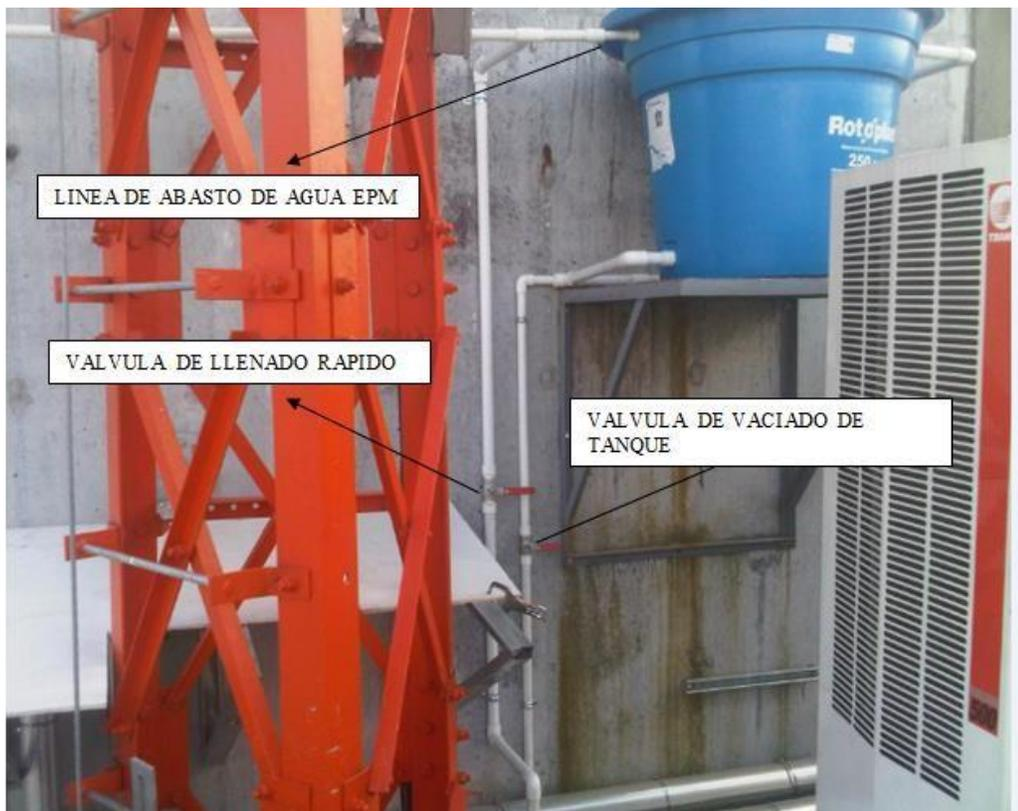
**Ilustración 4. Válvulas y línea de abasto**
