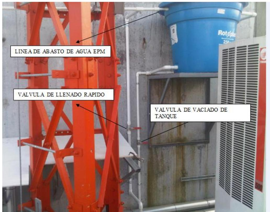
Ilustración 2. Válvulas y línea de abasto
