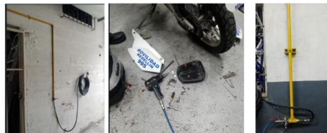
Manguera de servicio Pistola neumática taller motos Conexión red taller motos
